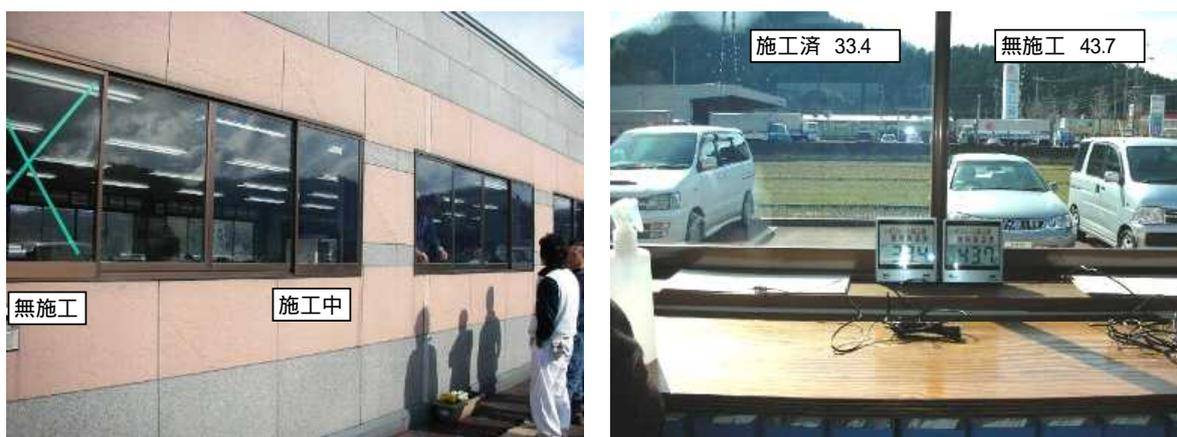
図5 断熱ガラスガード施工風景と 窓からの日射熱測定
